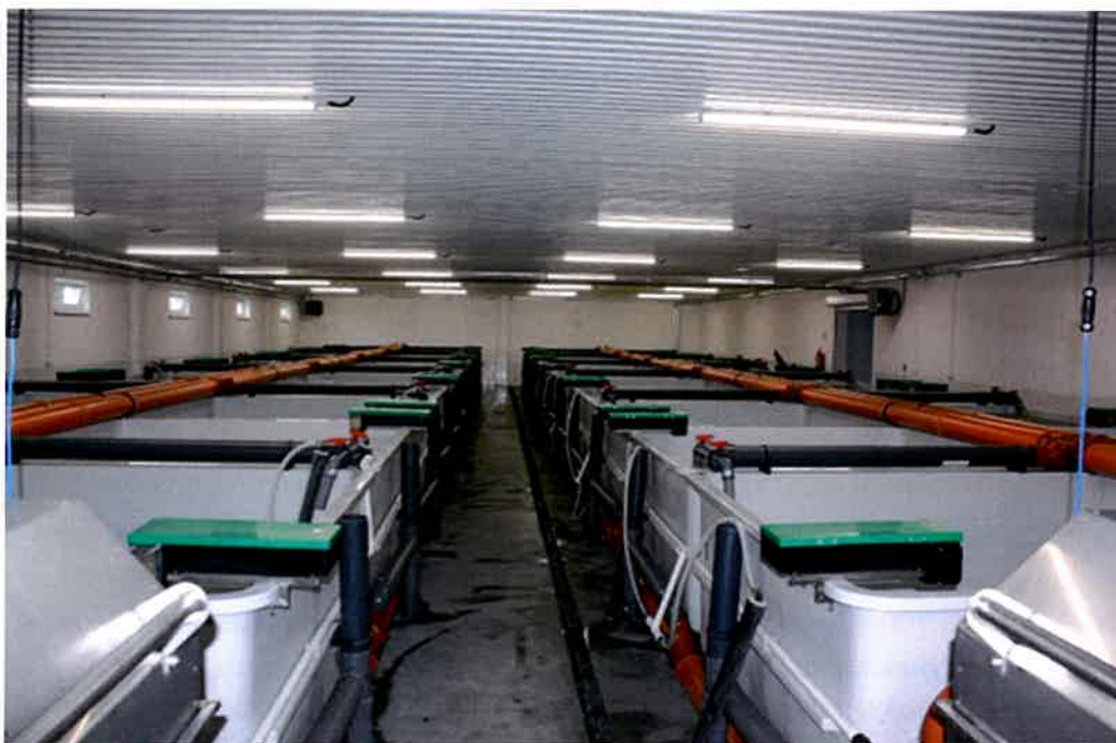
Fot. 1. Eksperymentalny system zwrotnego obiegu wody (eRAS) (fot. J. Mazurkiewicz).
